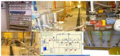
El proyecto consistió en desarrollar las instalaciones de ductería eléctrica y neumática, además de la instrumentación del control y el diseño y desarrollo de software para llevar a cabo calibraciones de medidores de hidrocarburos, ya sea con probador o con medidor maestro. El impacto de este proyecto radica en el sentido de que permitirá al cliente disponer del primer laboratorio para calibración de medidores de hidrocarburos, el cual se convertirá en patrón nacional para estos medidores.
